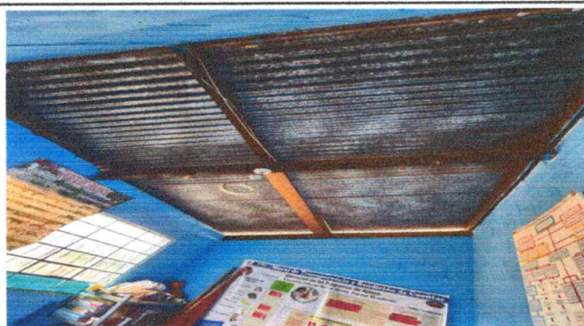
Foto 3: Sustitución de estructura de soporte de madera, por metal en aulas
