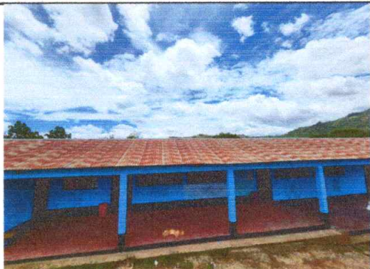
Foto 1: Sustitución de lámina por lámina troquelada aluzinc calibre 26 en aulas
