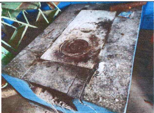
Foto 5: Reparación de estufa rural
