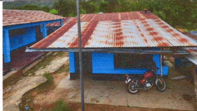
Foto 4: Sustitución de lámina por lámina troquelada aluzinc calibre 26 en cocina
