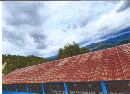
Foto 2: Sustitución de lámina por lámina troquelada aluzinc calibre 26 en aulas
