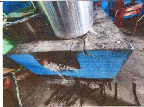
Foto 6: Reparación de estufa rural
